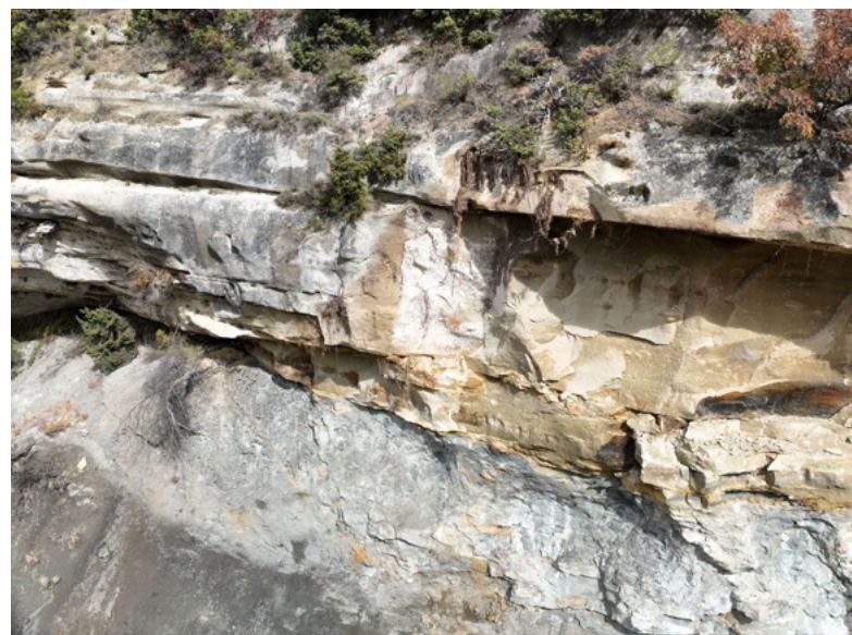
Το τμήμα βράχου που «κρέμεται» πάνω από το οδόστρωμα και κινδυνεύει να πέσει
