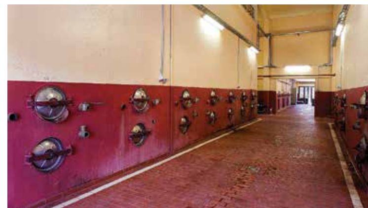
Οι τσιμεντένιες δεξαμενές του οινοποιείου του Αγροτικού Συνεταιρισμού Αμυνταίου
